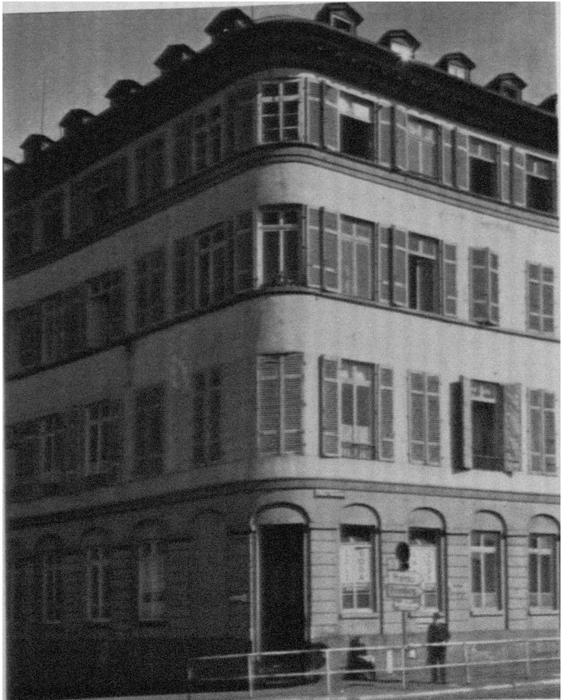
Abbildung E.2. Haus an der Ecke Schöne Aussicht und Fahrgasse. Nach Vogt wurde die runde Ecke nachträglich hinzugefügt.
