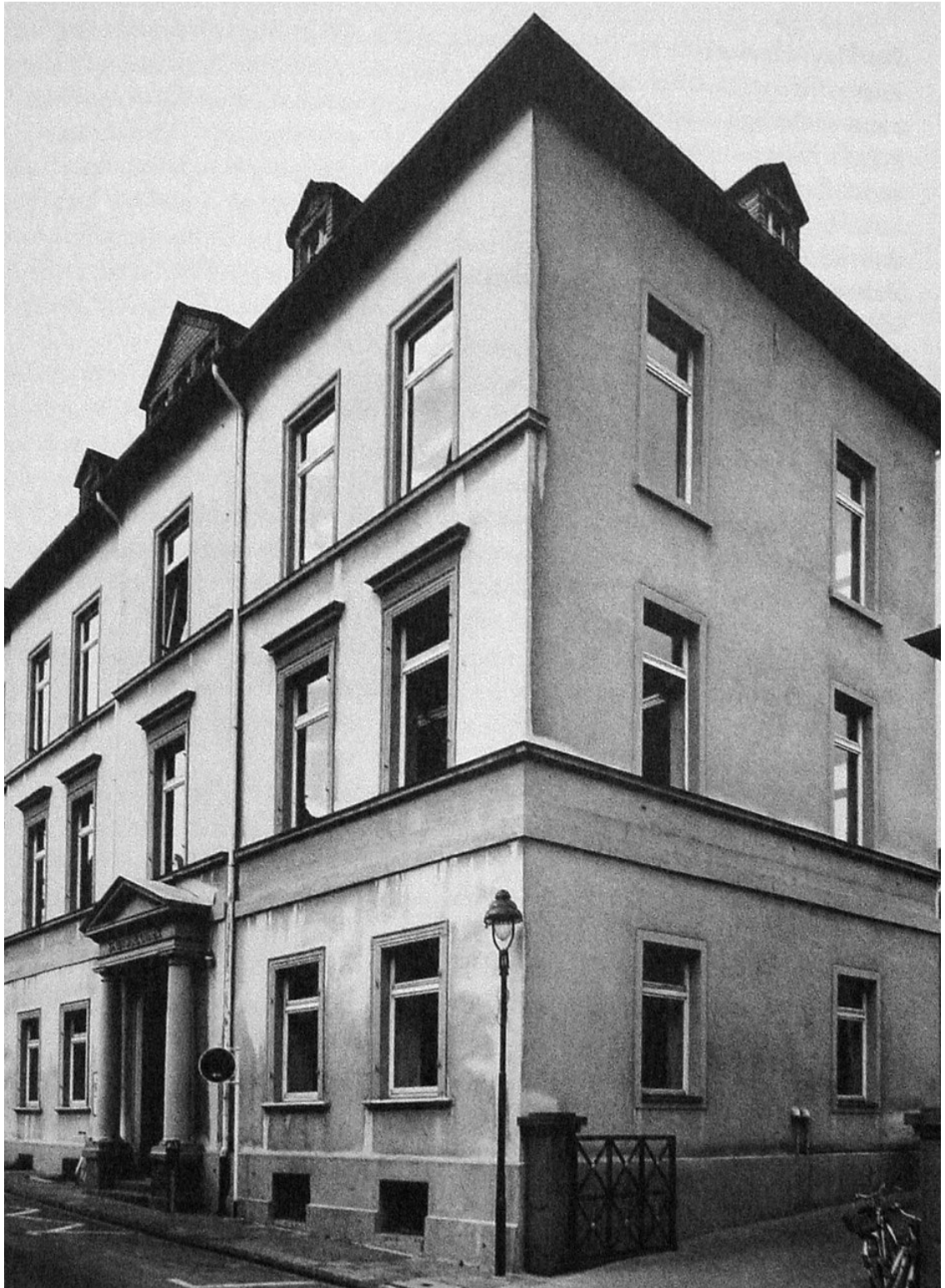
Ehemaliges Amtsgericht in Bad Homburg; Fotografie von M. Matthews und P. Seidel, 1985; Hils 1988 Abb. 59
